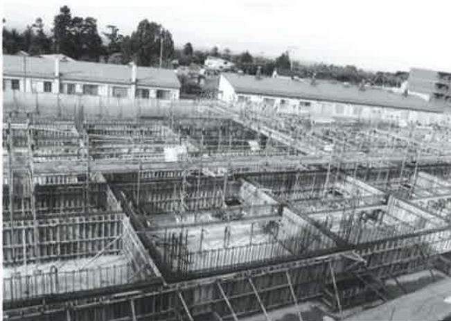
躯体の型となる型枠工事
