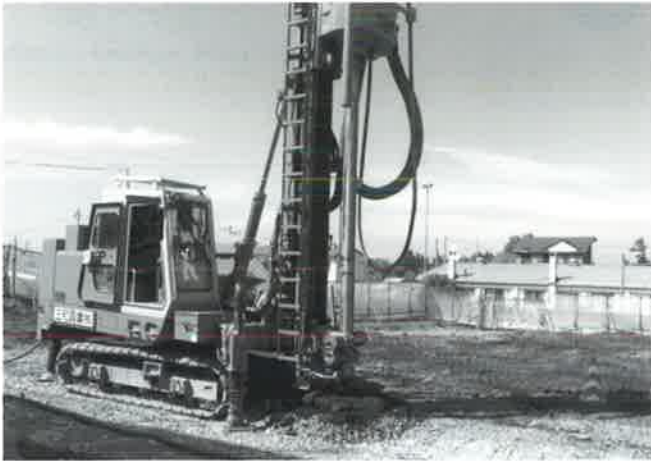
地盤改良工事
