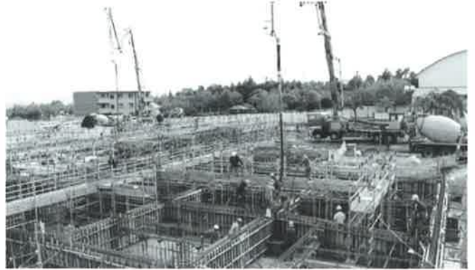
ポンプ車で圧送して型枠の中へ流しこむ
