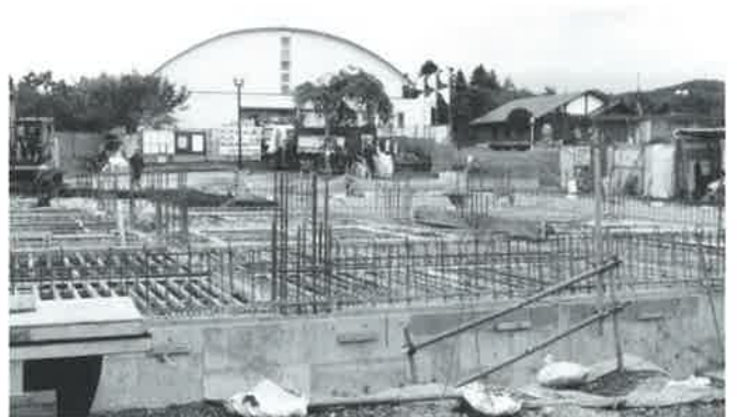
基礎コンクリート完成
