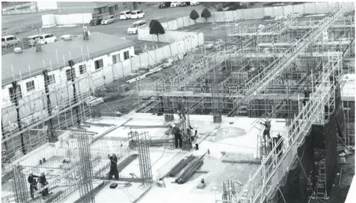
工事の状況全景
