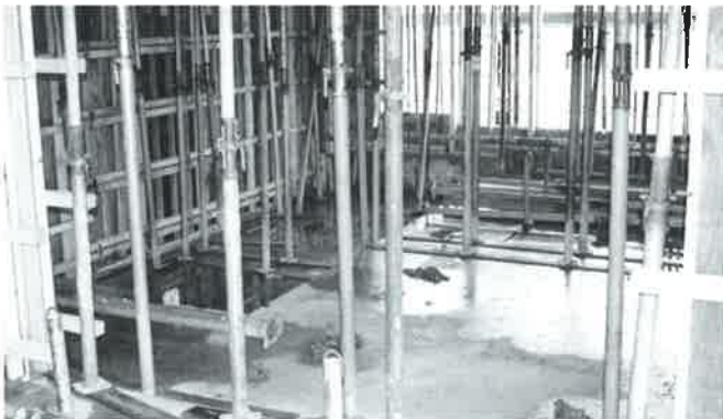
内部型枠部分
