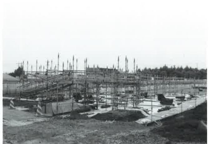
足場組立作業
