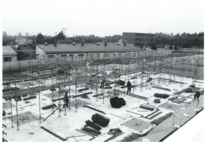
鉄筋組立作業
