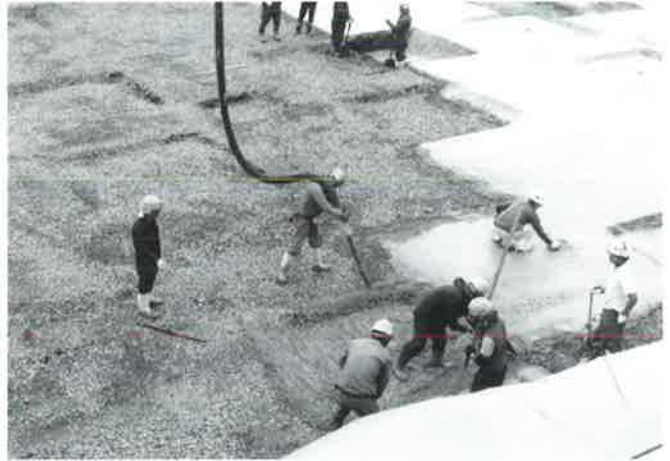
コンクリート均等ならし作業
