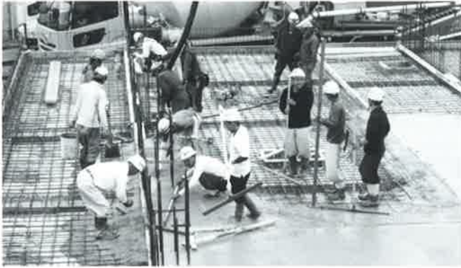
スラブコンクリート打作業
